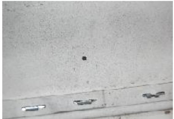
Anschließend mit einem Kegelbohrer auf 18,5 mm aufbohren.
